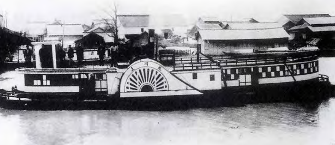
上川丸は明治22年竣工。長さ23m、幅4m、60 t、速力時速15km、60名収容で、昭和8年まで活躍した。 国土交通省北海道開発局所蔵
