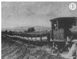
①排水のための管を1本1本、埋設する人々。写真は重機による開削だが、排水溝は長い間、手掘りだった。②開拓期から昭和40年代まで行われていた、馬糧(ばそり)による客土。③線路を引いて行われた軌道客土。昭和20年撮影。
