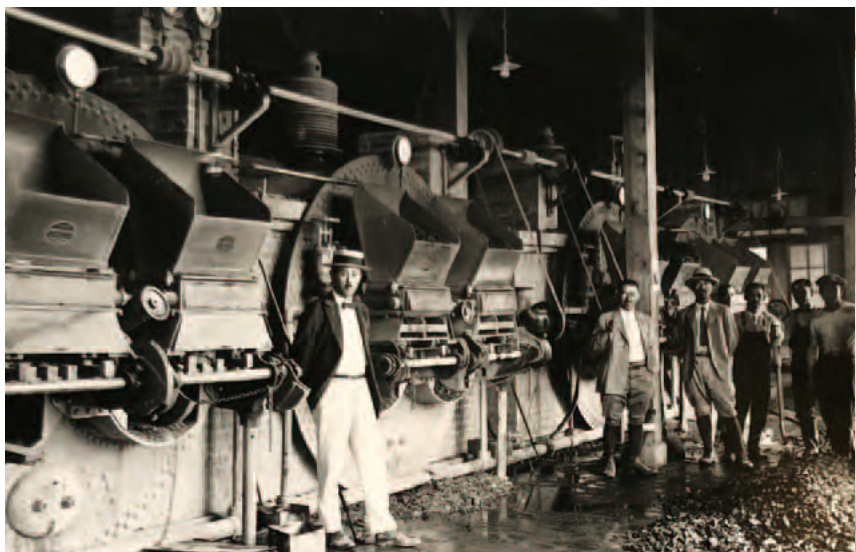
石狩川の水を灌漑に使うための北村揚水機場取水口（右）と、揚水機を動かす蒸気機関（左）。当初、蒸気機関の燃料は石炭を使ったが、余剰電力を安く利用できる電力に転換。その際、暲は農家が利用できるよう電力会社に働きかけ、北村地域に初めて電灯がついた。
