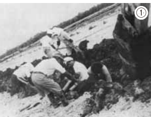
①排水のための管を1本1本、埋設する人々。写真は重機による開削だが、排水溝は長い間、手掘りだった。②開拓期から昭和40年代まで行われていた、馬糧(ばそり)による客土。③線路を引いて行われた軌道客土。昭和20年撮影。
